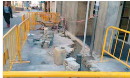
Les obres han començat aquesta setmana als accessos de l'illa de vianants de la Platja ■ AJUNTAMENT DE CALAFELL
